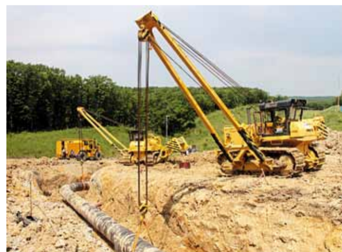
Огневые работы на 2-м километре газопровода-отвода к Владивостоку
